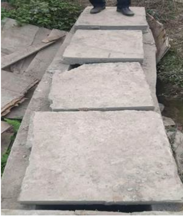
आर.सि.सी. नालाको केहि तस्बिरहरु
